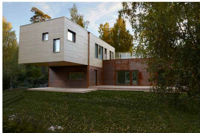
Friendly Building - Stockholm (Maximus Home) Installation i olika passivhus i Stockholmsområdet.
