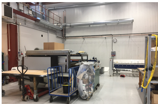
Falu Ventilation, Falun (TubusRaw)
