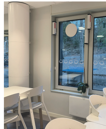
Passivhuset Skapaskolan (F-9) nominerades till Årets Bygge 2019 och har valt InventiAirs ventilationsdon Tubus som distribuerar tilluft längs väggarna. Foto: InventiAir
